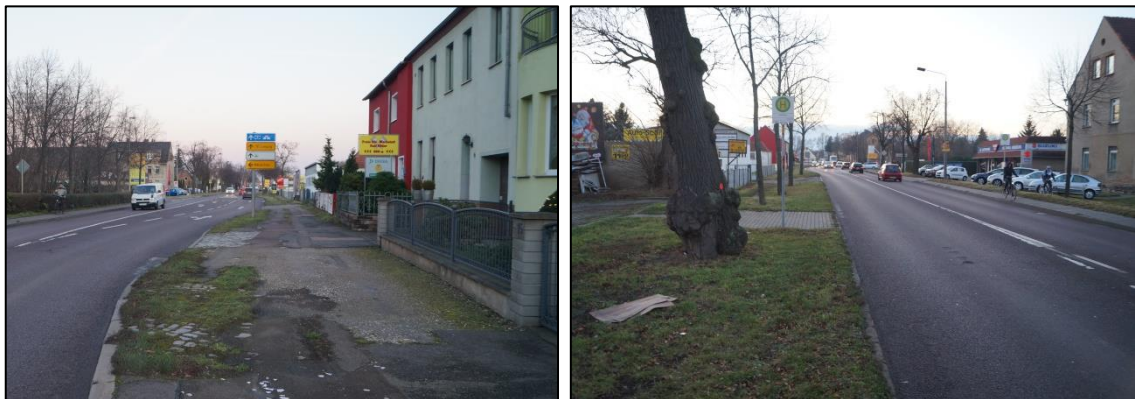
Abb. 4 Defizite im Bereich B 181 Amtshäuser
