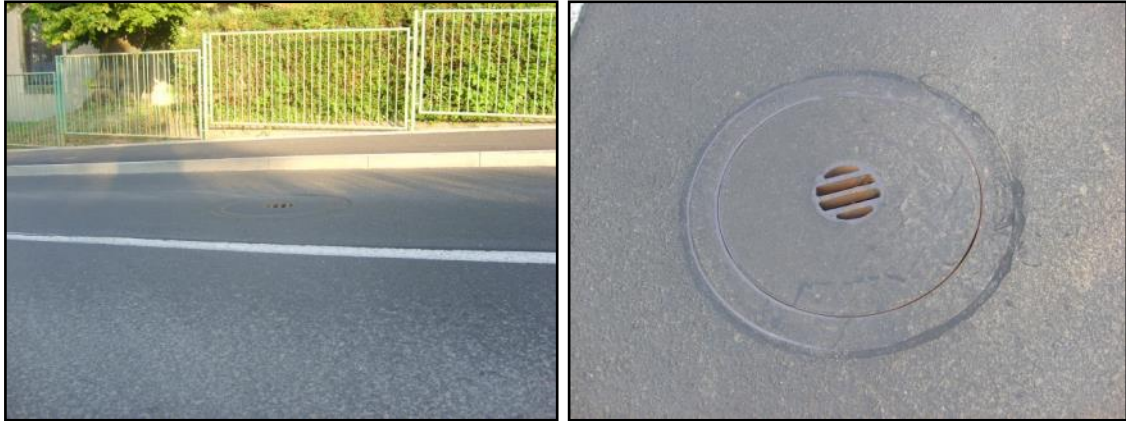
Abb. 31 Lärmarme Schachteindeckung (Beispiel Dresden)
